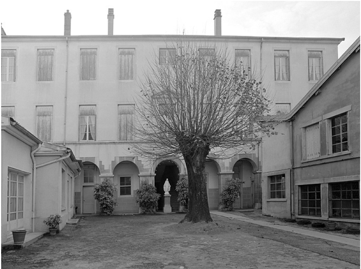
Bâtiment annexe, façade sur la cour.
