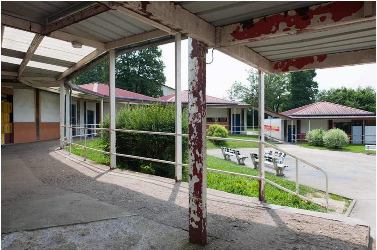
Vue générale de la galerie couverte.
