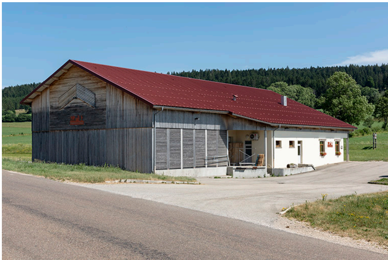
Façades postérieure et latérale gauche.
