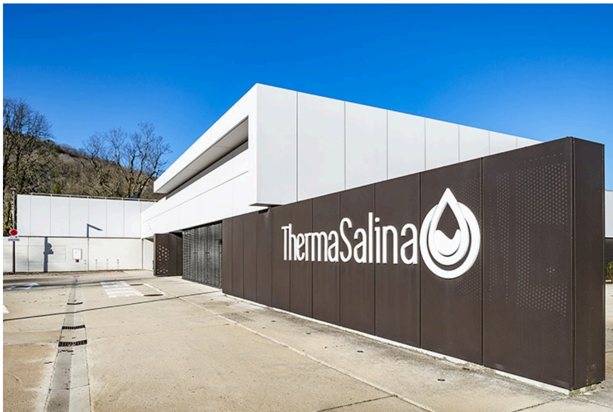
Façade sud, accès principal des curistes, depuis l'est.
