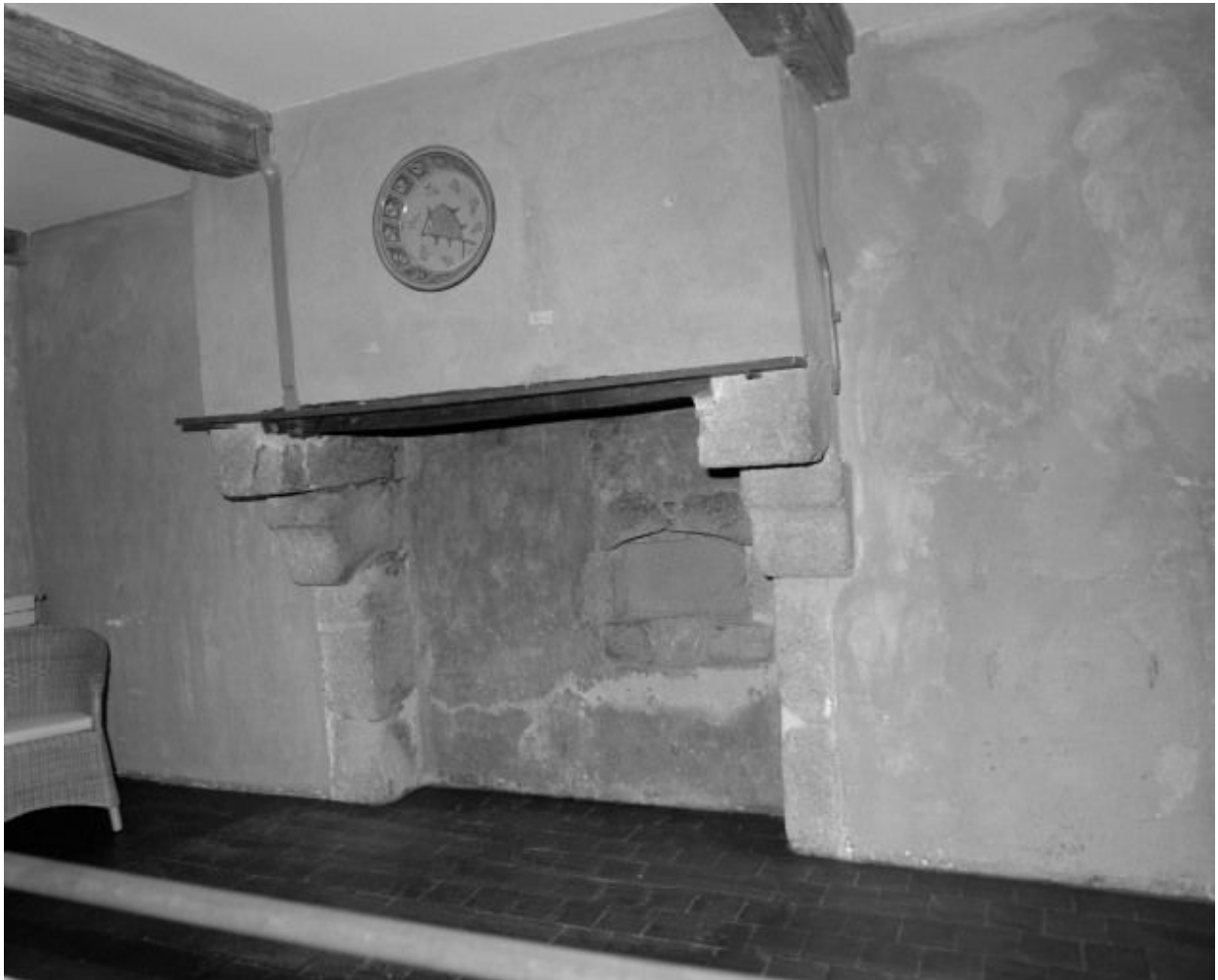
Vue d'ensemble d'une cheminée.
