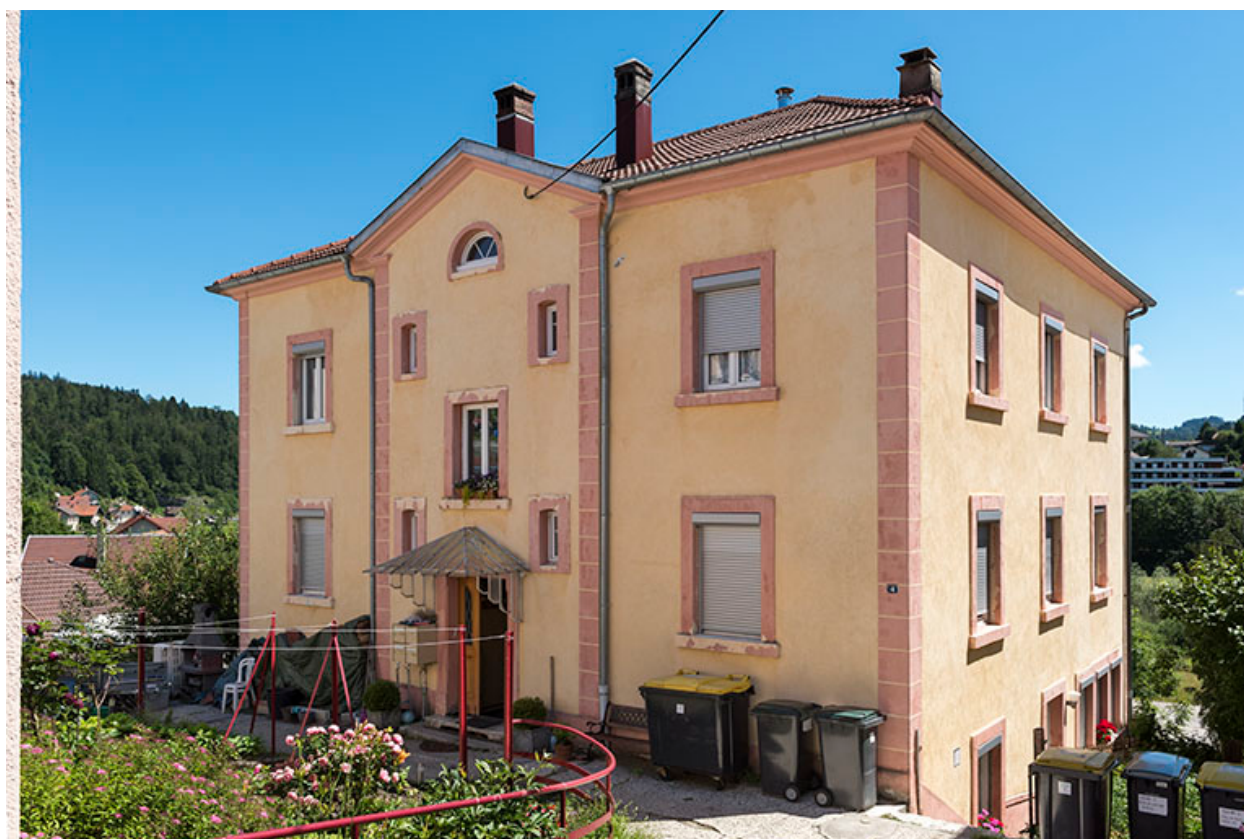
Façades antérieure et latérale droite.
