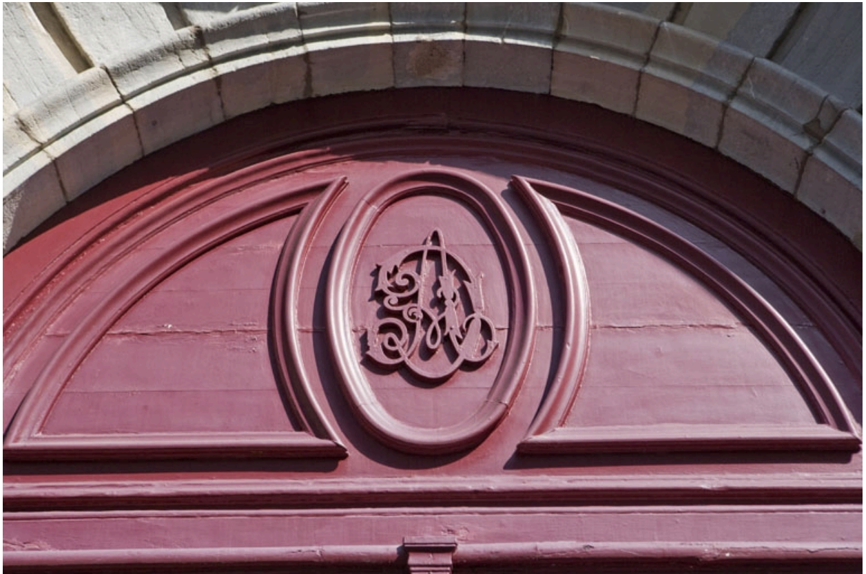
Détail du tympan en menuiserie du portail d'entrée.
