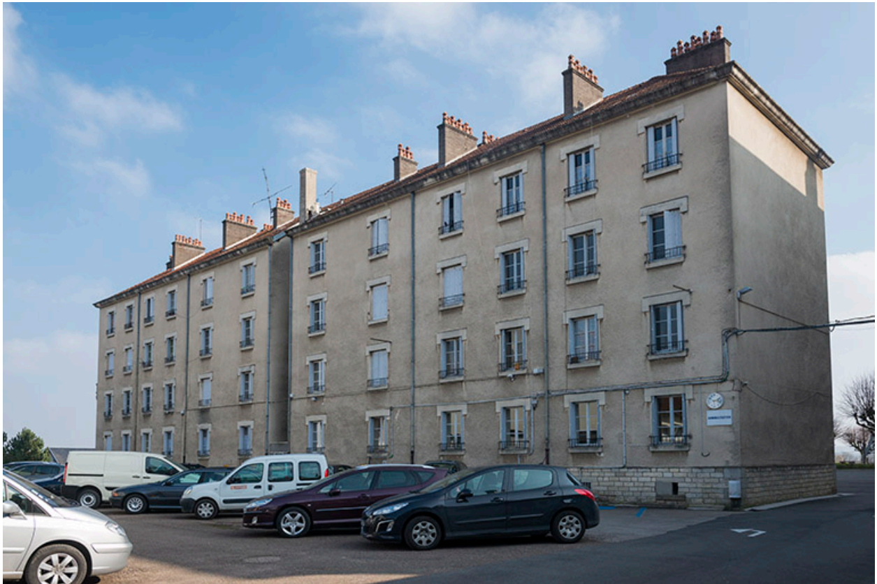
Façade postérieure nord-ouest des logements et administration.
