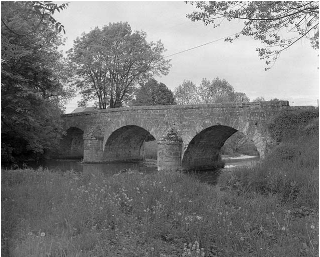
Face amont, vue de trois quarts
