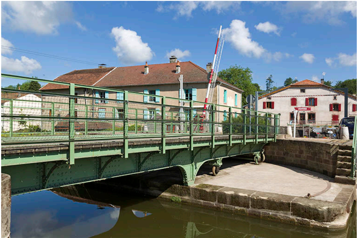
Le tablier métallique et sa plateforme.
