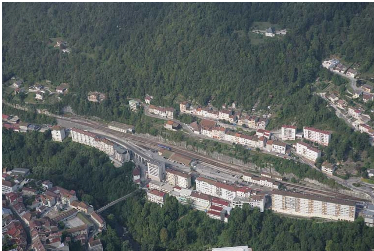
Vue aérienne, depuis le nord-est.
