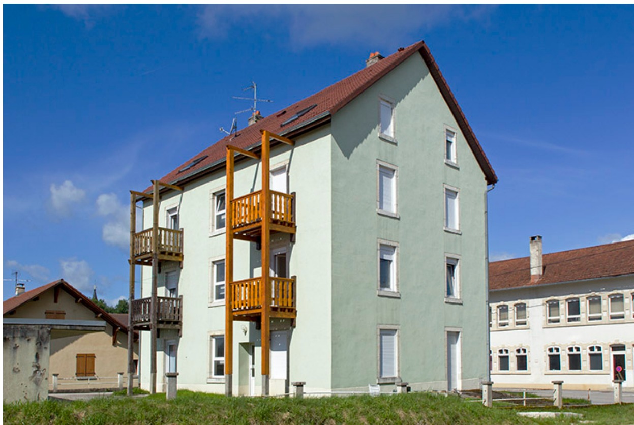
Façades postérieure et latérale gauche.
