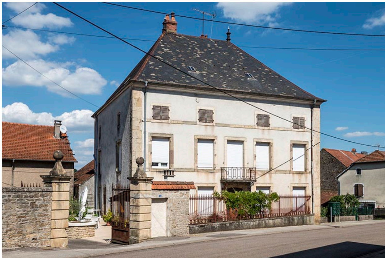
La façade antérieure.
