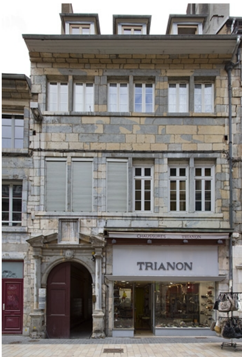
Façade antérieure du logis principal : de face.
