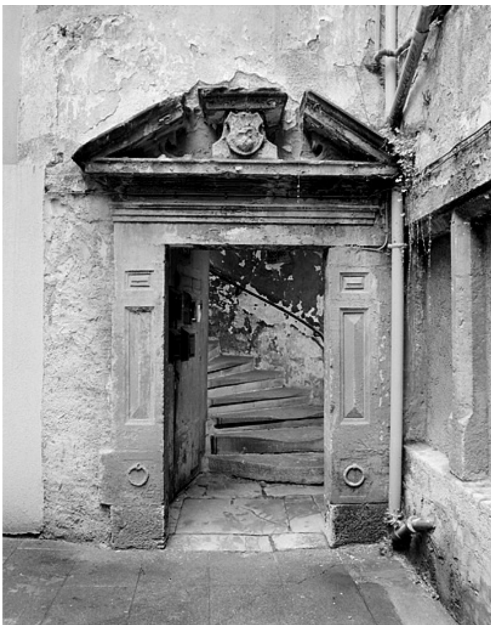
Porte de la tour d'escalier.
