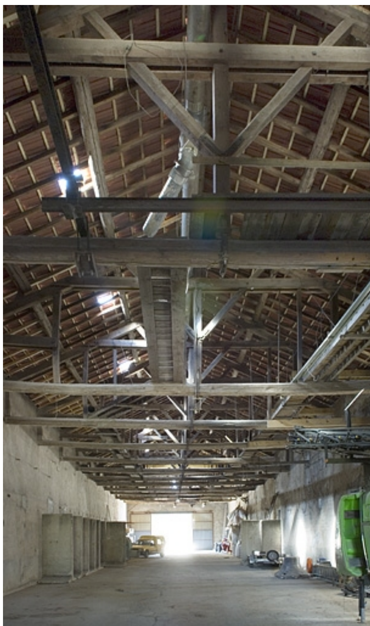
Intérieur de l'atelier de fabrication.
