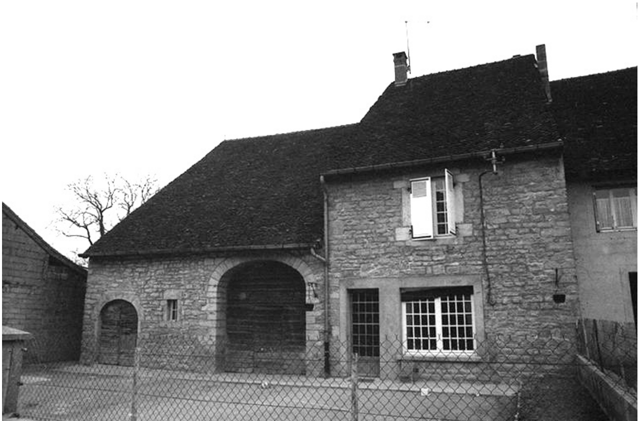
Ferme cadastrée 1961 AH 134, située rue des Guichard : façade antérieure.
