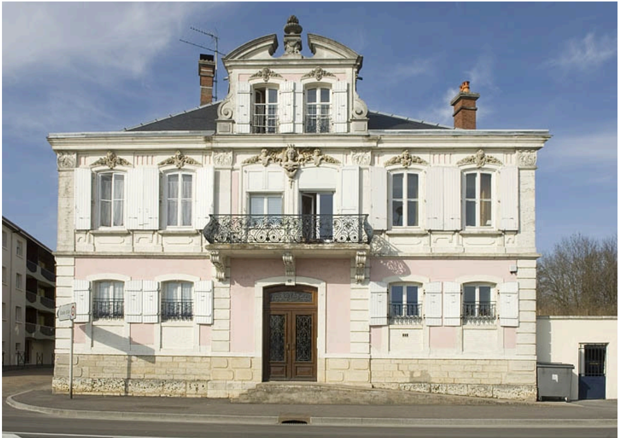
Vinaigrierie Clémentz : pignon du logement patronal.
