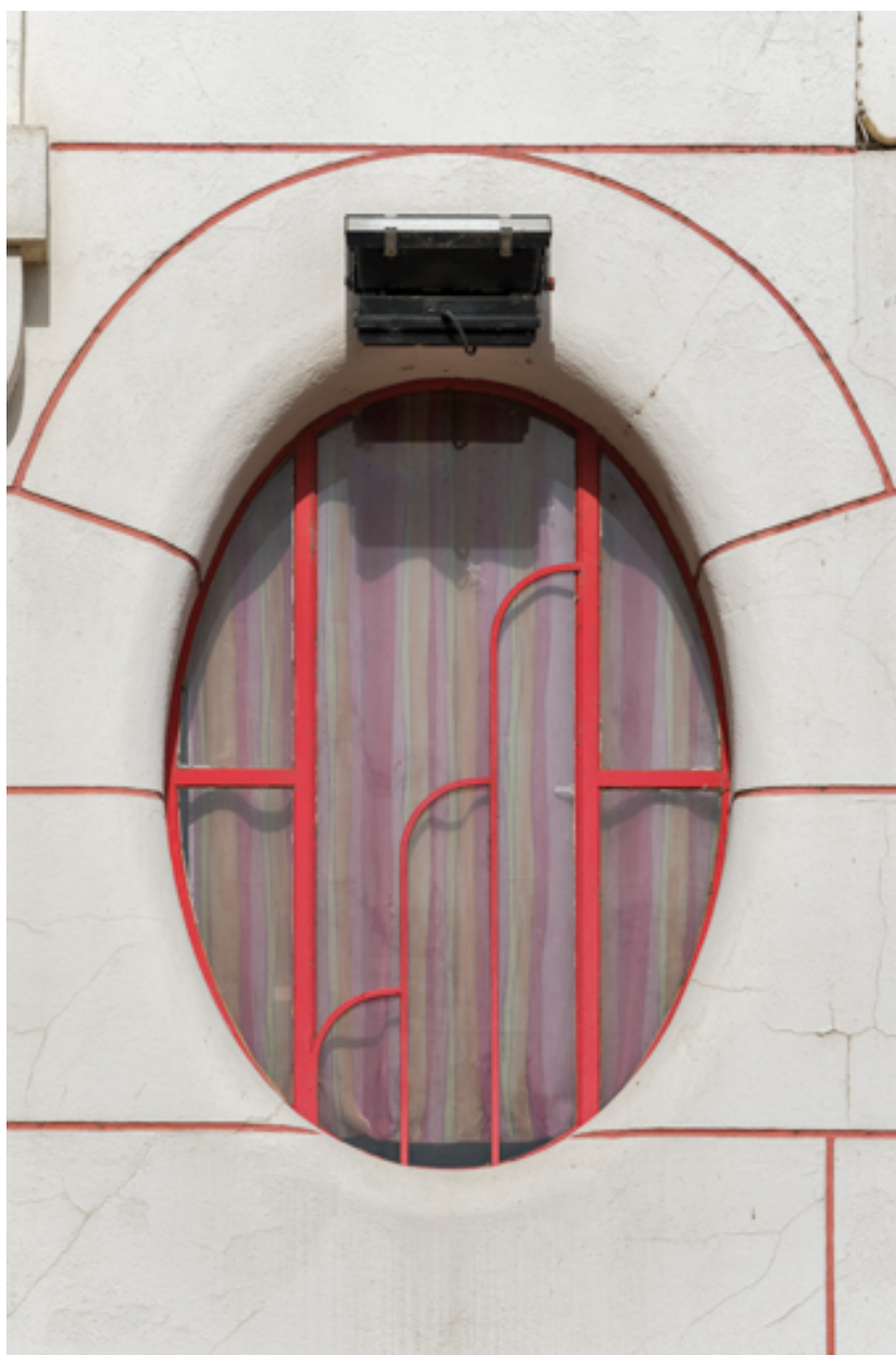
Façade antérieure, partie haute : oculus gauche.
