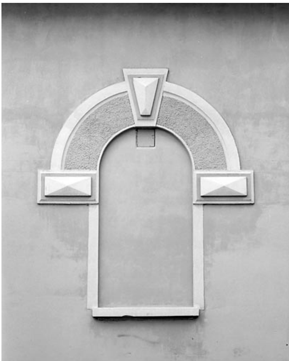
Détail d'une baie.
