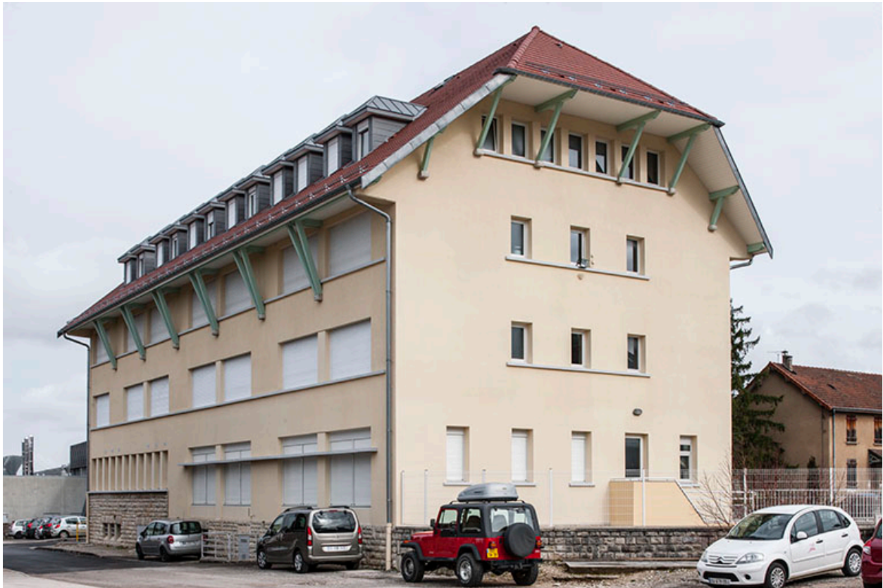
Angle sud-ouest et pignon sud de l'internat.
