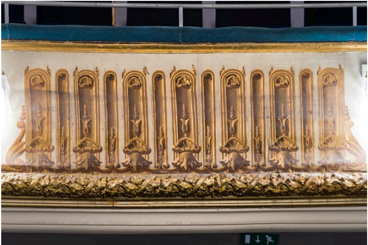
Décor peint du garde-corps du 3e balcon.
