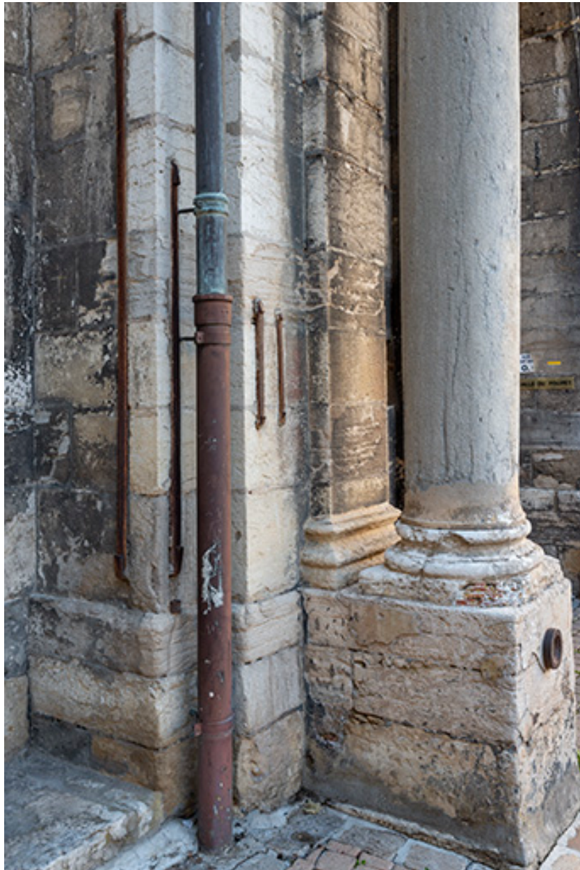
Toises métalliques (piédroit du passage couvert, corps de bâtiment principal).
