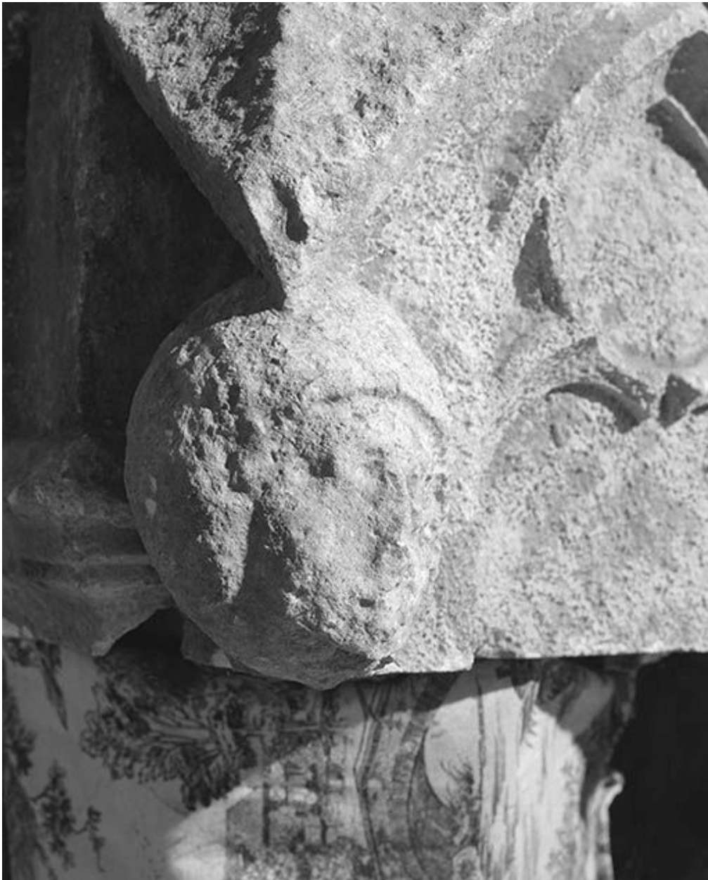
Pinacle du clocher n°1, déposé dans la nef, détail.
