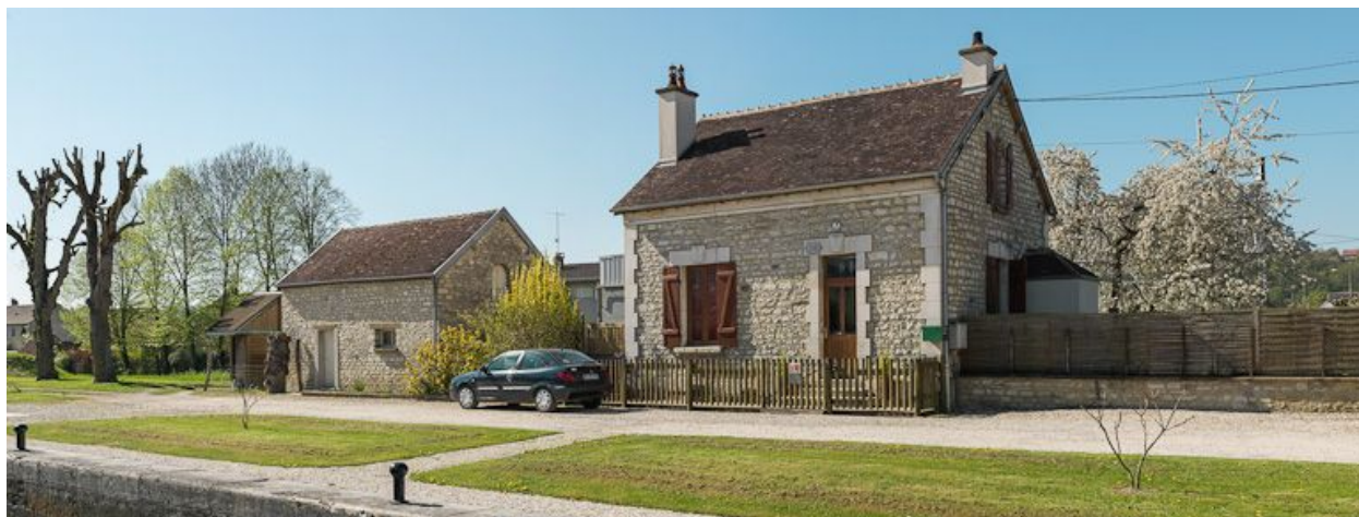
Vue d'ensemble de la maison éclusière.
