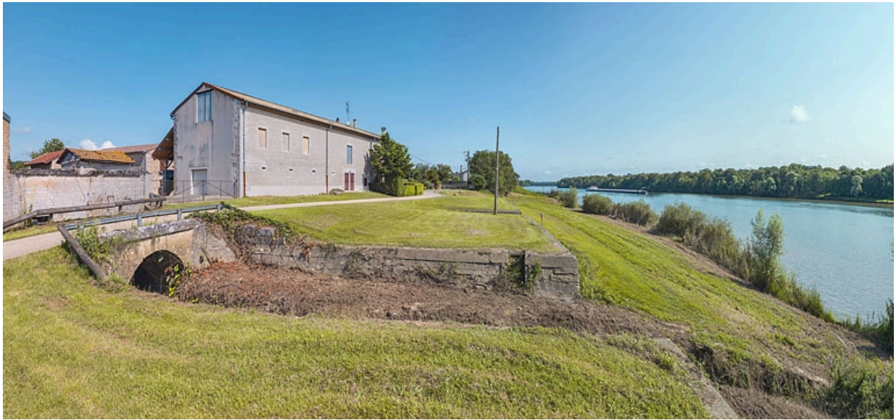
Le port de Farges : ponceau et mur de soutènement.
