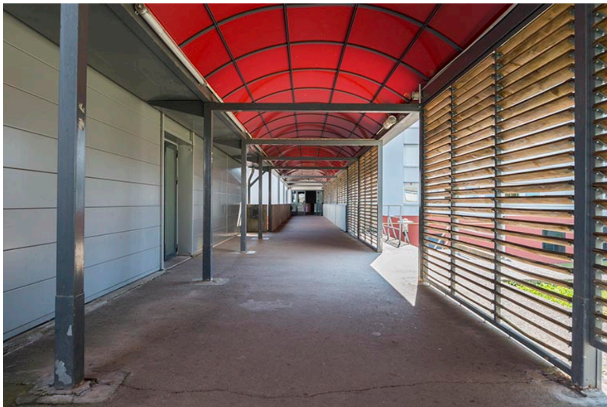
Détail des circulations abritées.
