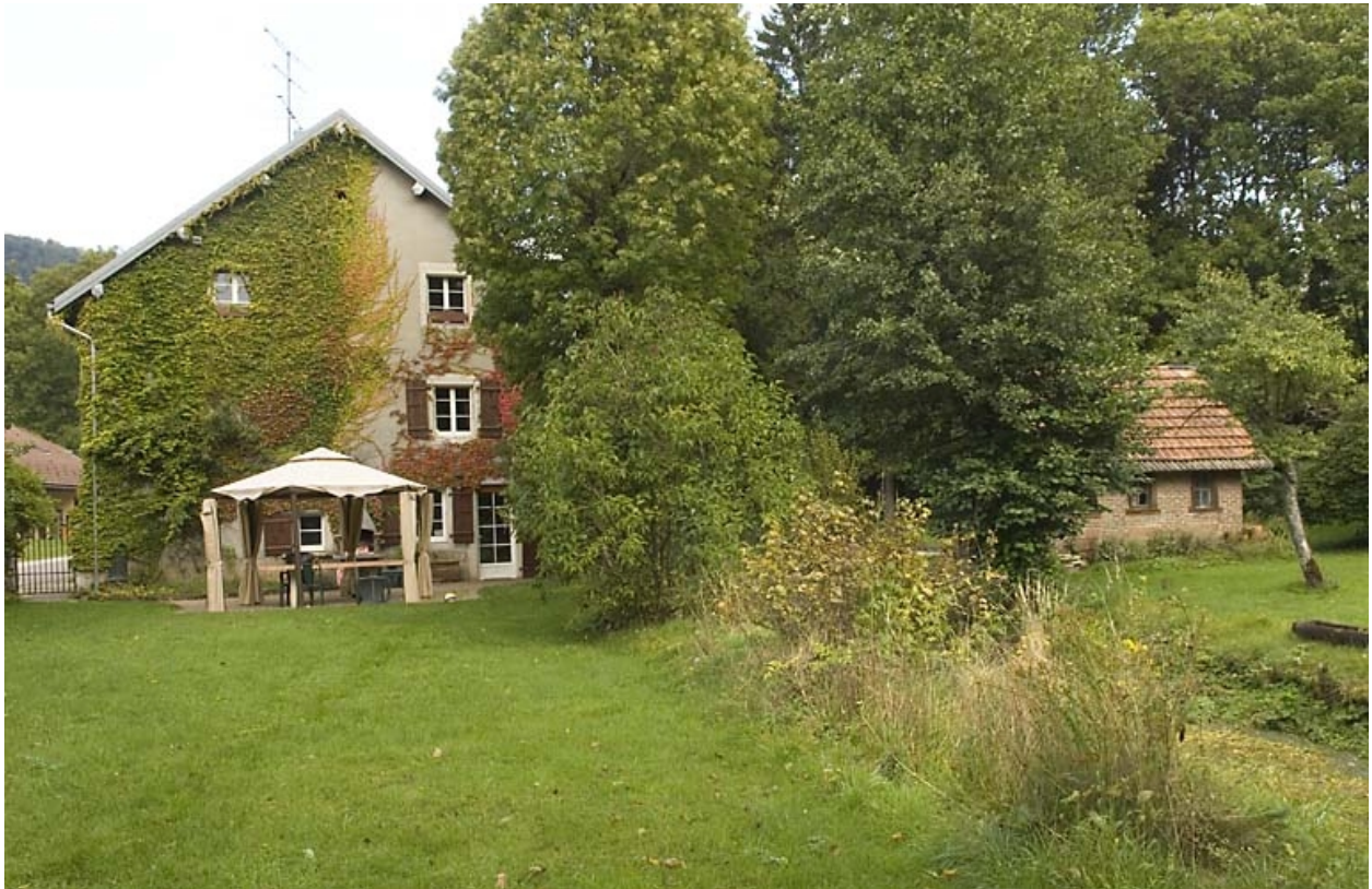
Maison : façade latérale droite.
