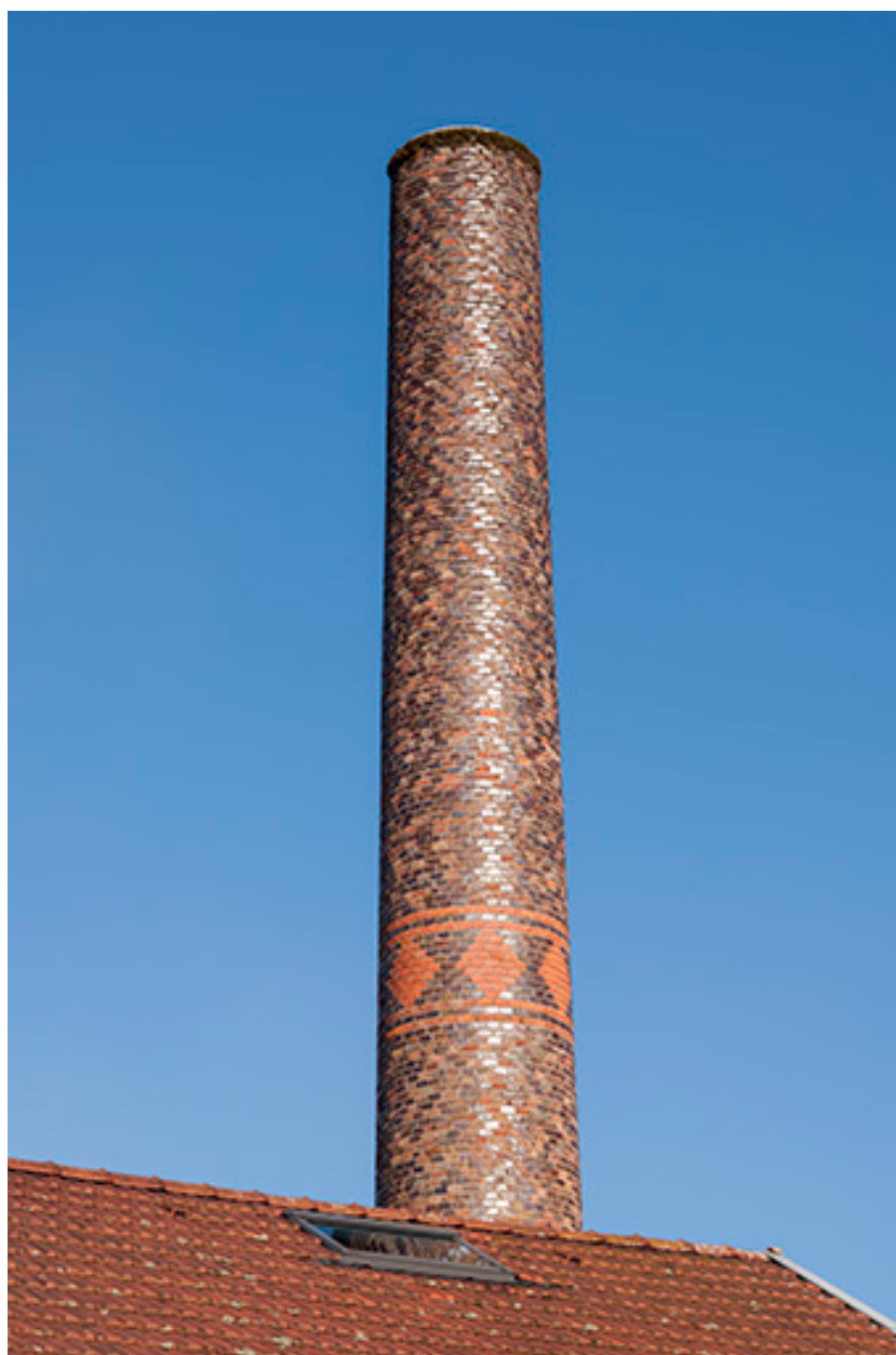
Cheminée de la chaufferie.
