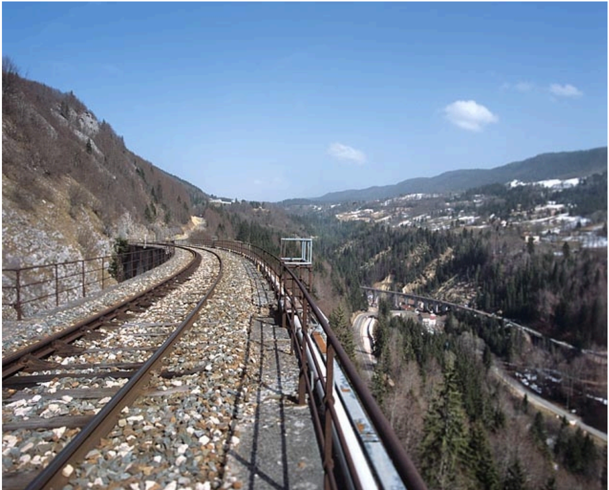
Vue d'ensemble du tablier et des garde-corps, depuis le côté Andelot-en-Montagne.
