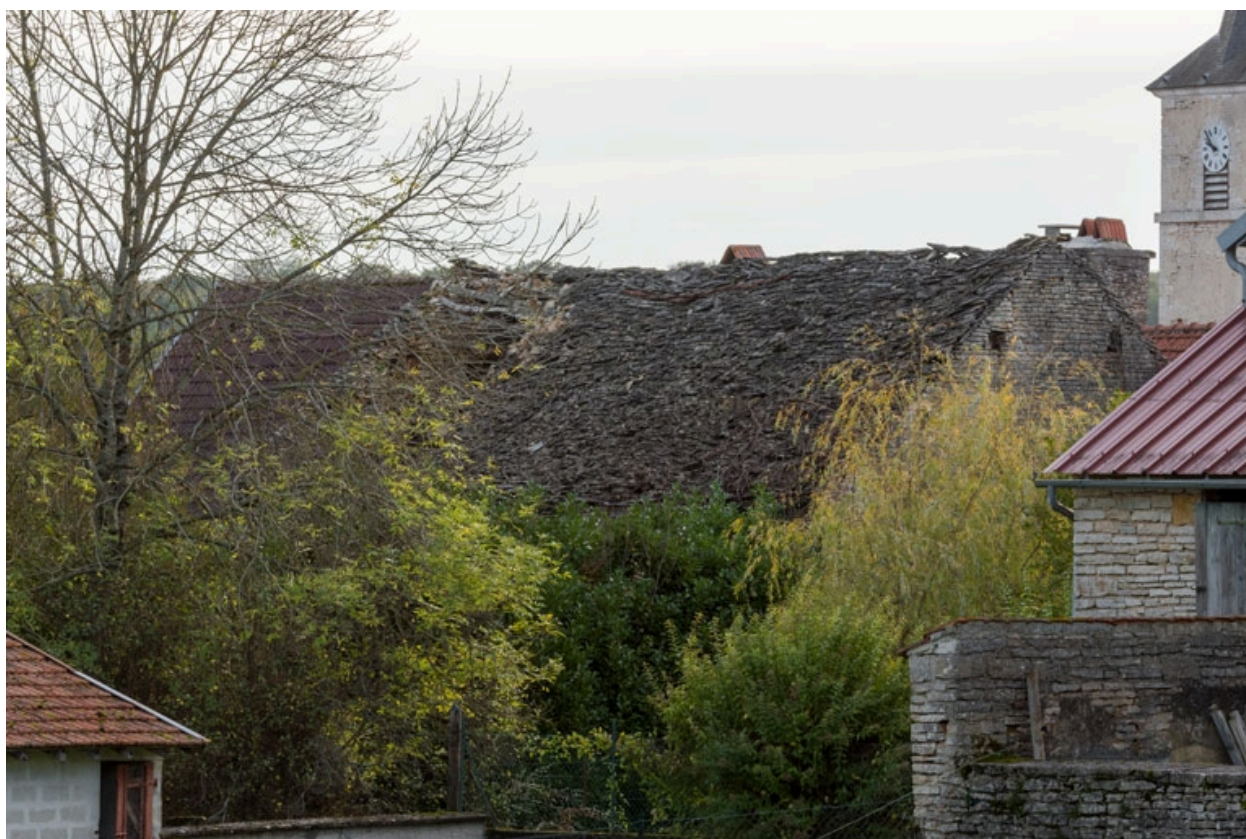
Vue nord de la toiture.
