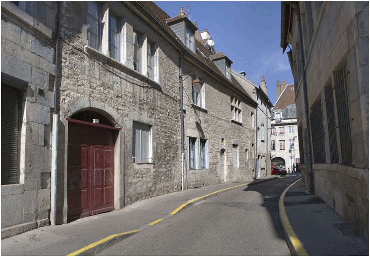
Façade latérale gauche, vue d'ensemble.
