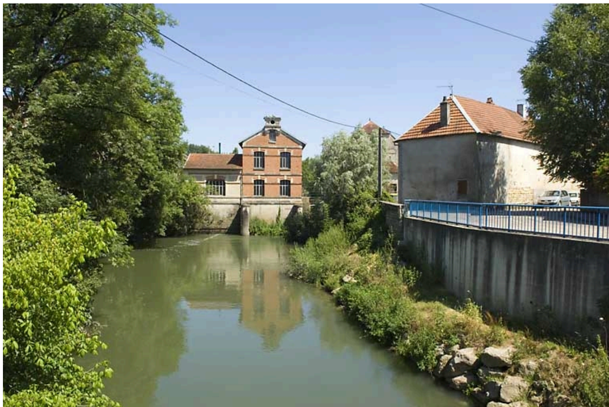
Usine de pâte à papier Outhenin-Chalandre puis fromagerie industrielle (cave d'affinage) de l'UCAFCO, Seveux : bâtiment d'eau et canal de fuite.
