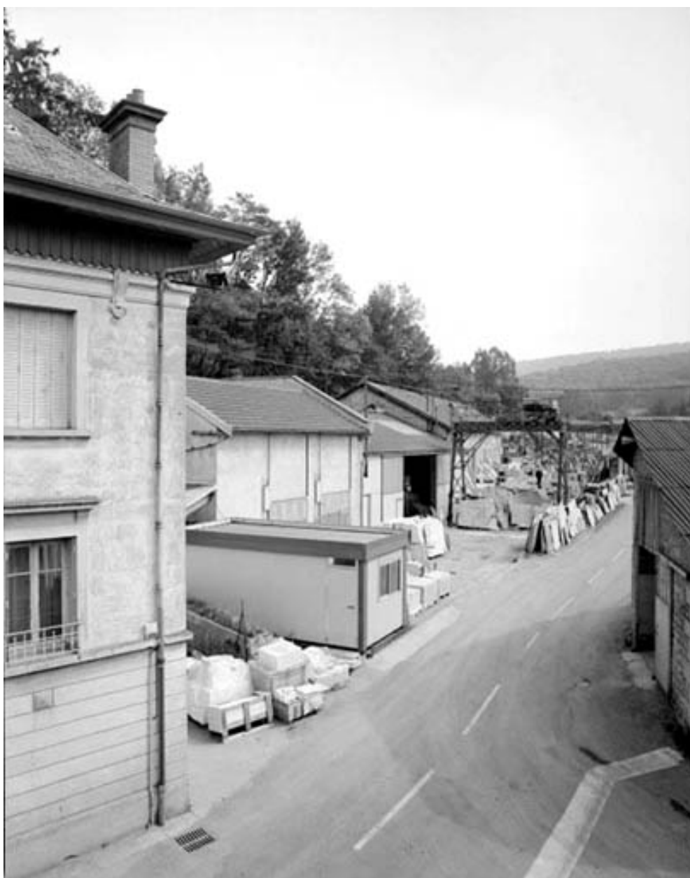
Atelier de fabrication, de trois quarts gauche.
