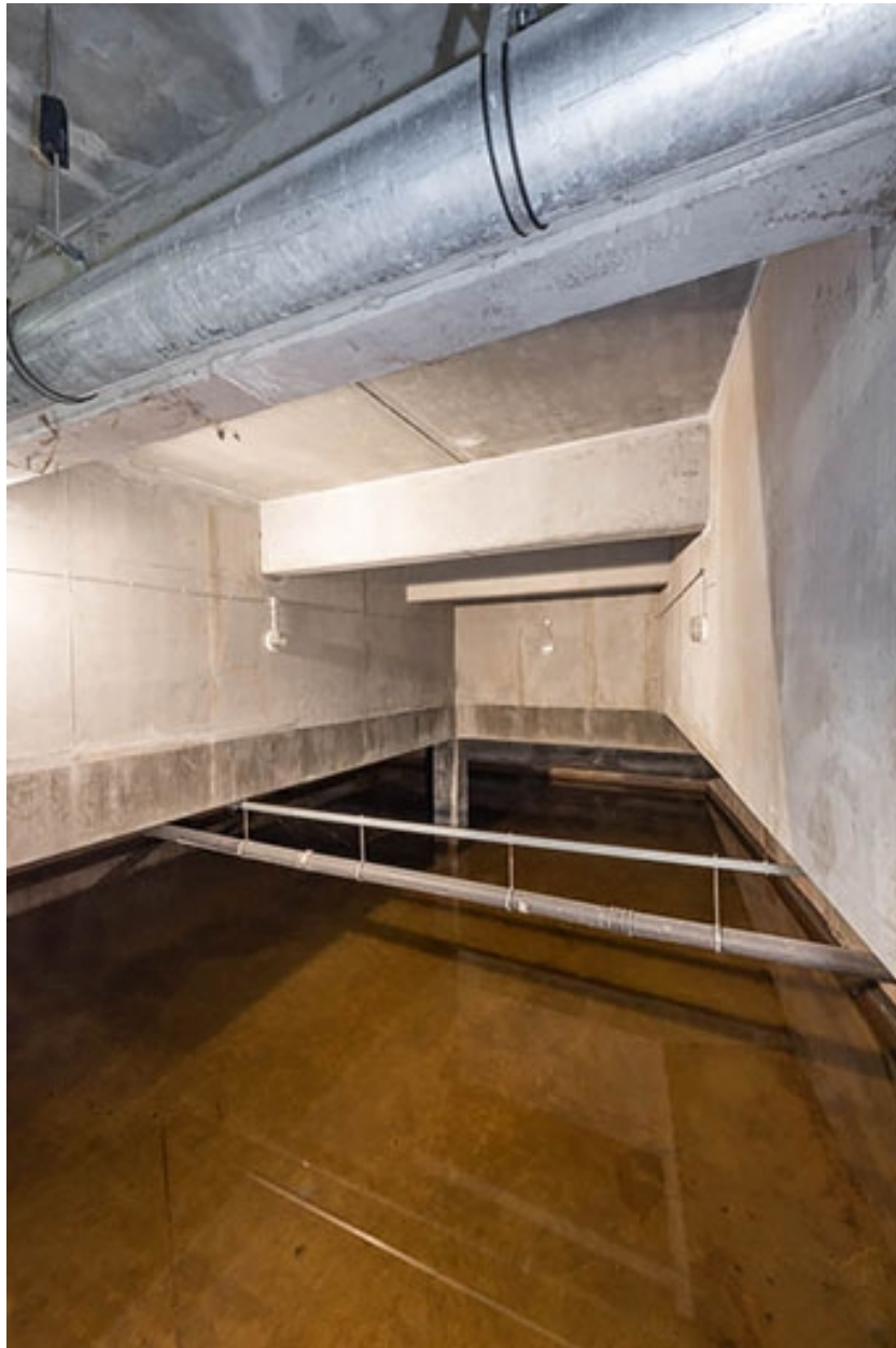
Bassin en sous-sol (350 m3).
