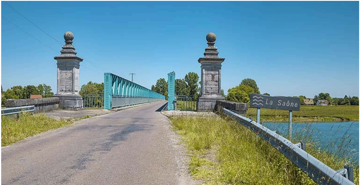
Entrée du pont.
