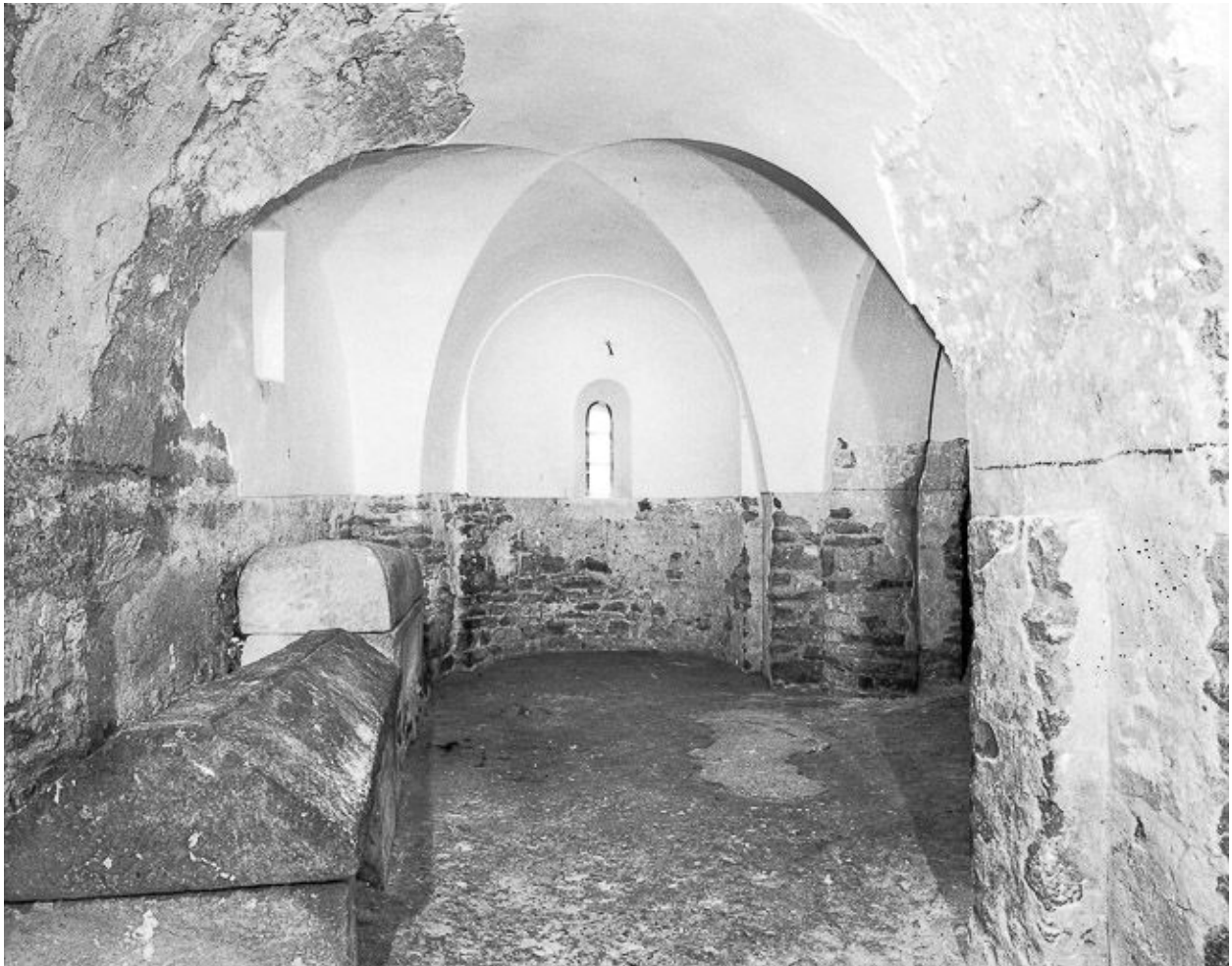
Intérieur : crypte, vaisseau gauche vu depuis l'ouest.
