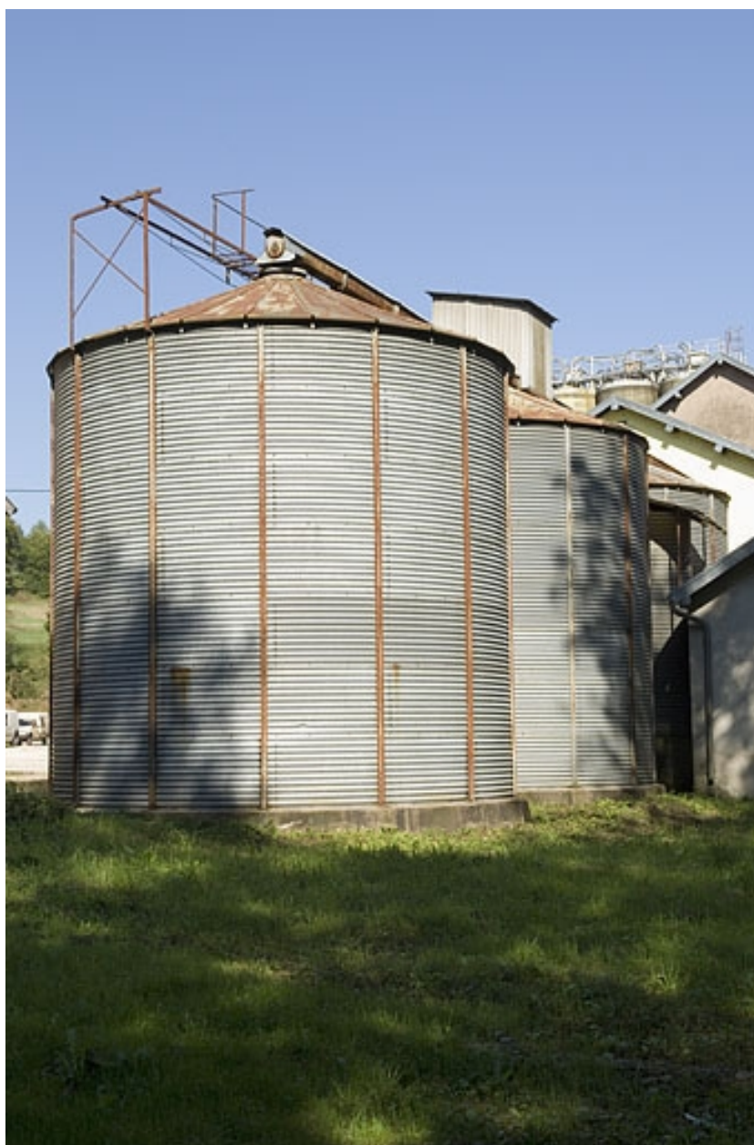
Silos métalliques. Vue depuis l'ouest.
