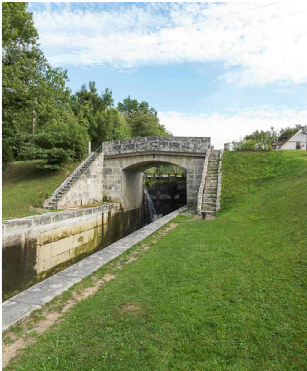
Vue d'ensemble du pont.
