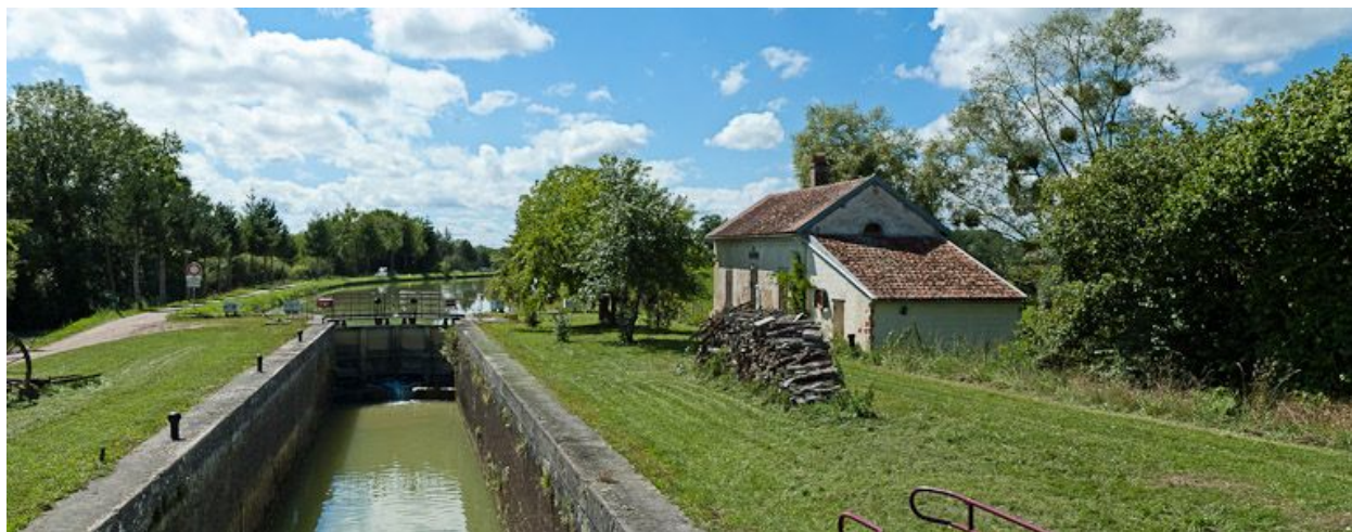
Vue d'ensemble du site d'écluse.
