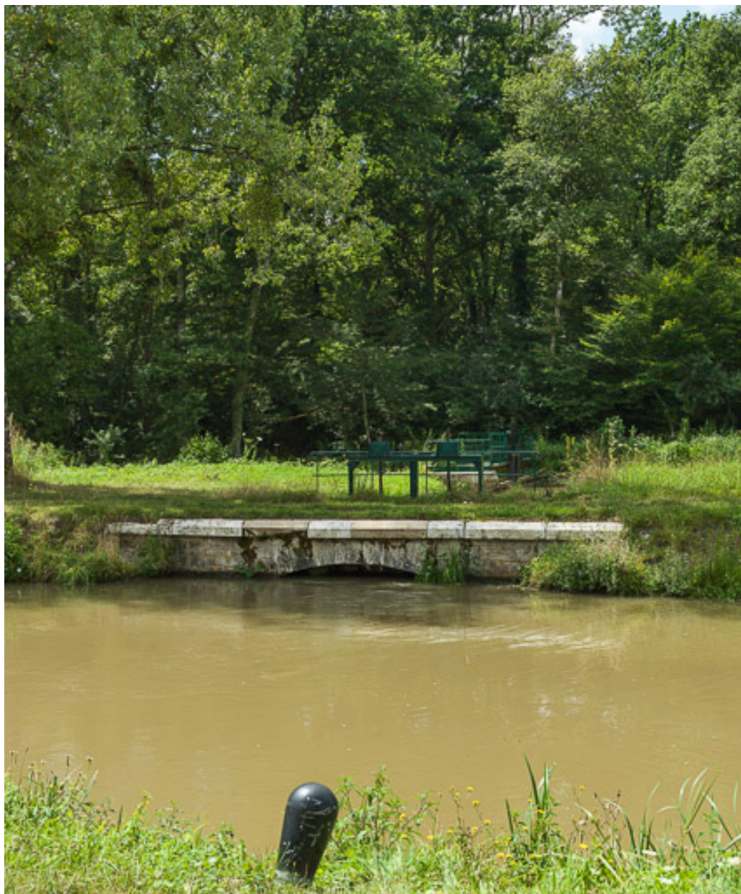
Vue de la prise d'eau.
