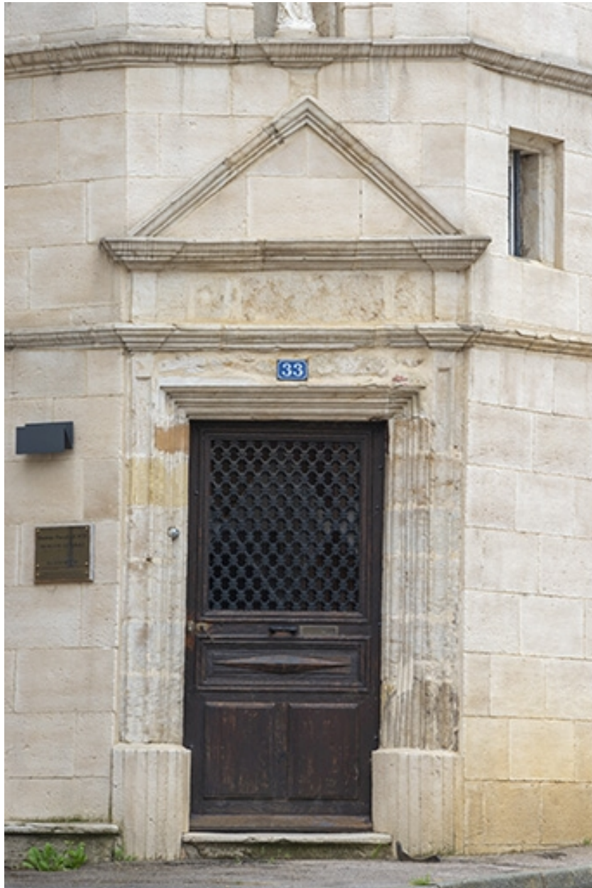
Vue rapprochée de la porte d'entrée.
