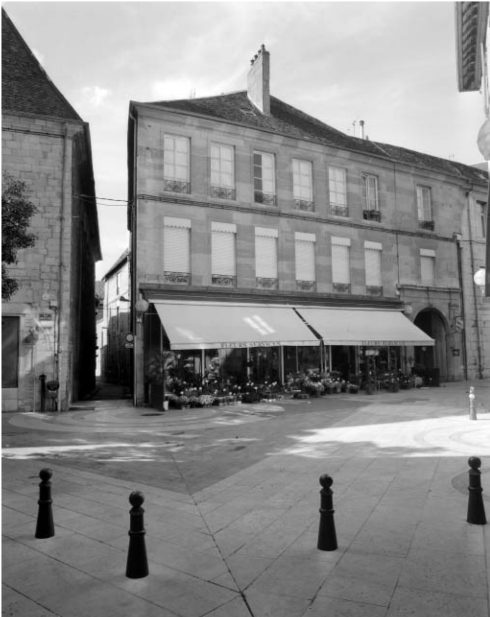
Façade sur rue : détail de la partie gauche.
