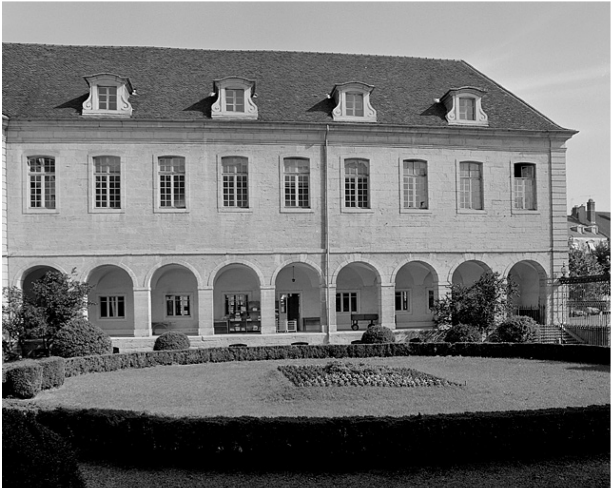
Façade latérale de l'aile droite en retour donnant sur la cour ouverte.
