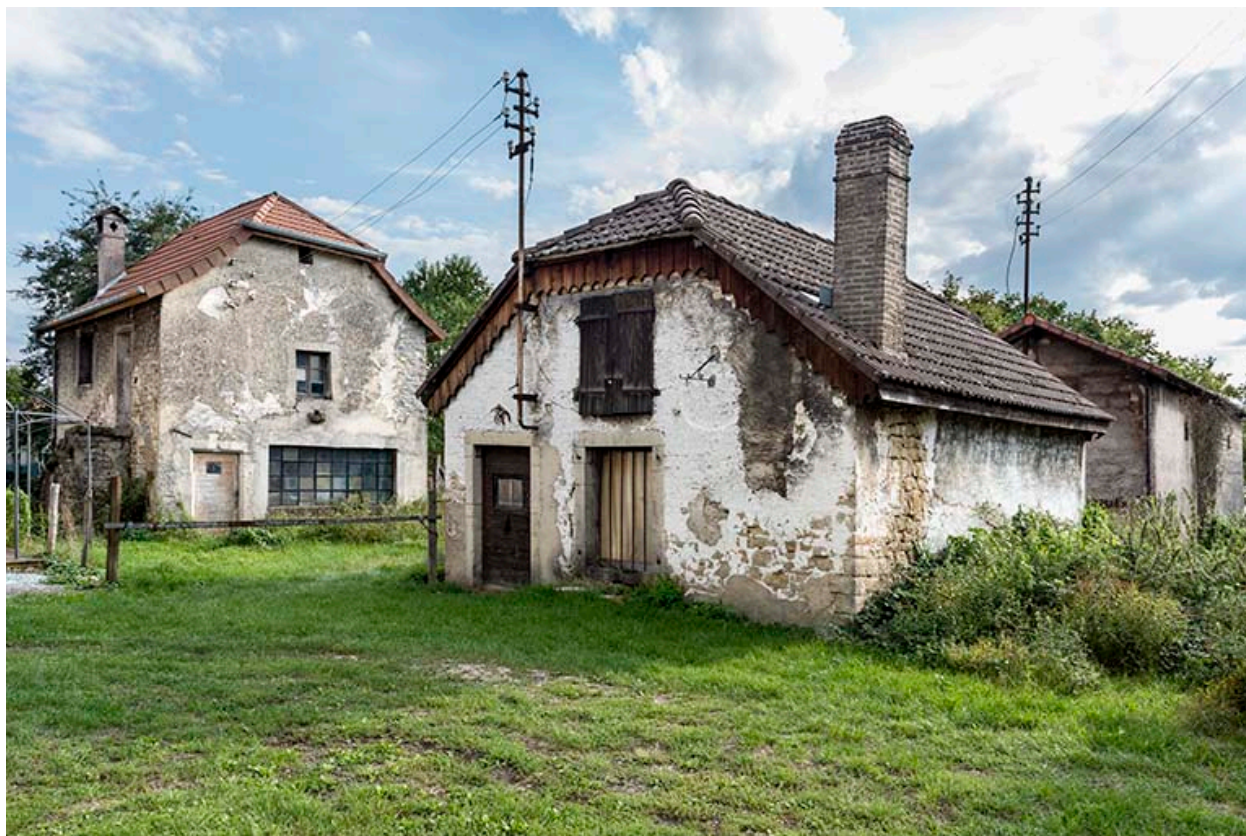
Usine d'outillage E. Ducommun et Marti puis FMX, Montécheroux (55, 66 Grande Rue) : "forges maisonnettes".
