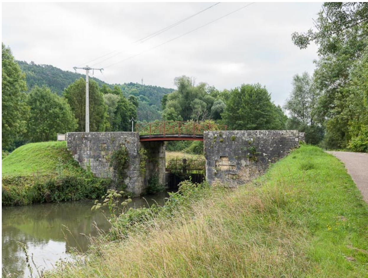
Vue du pont.
