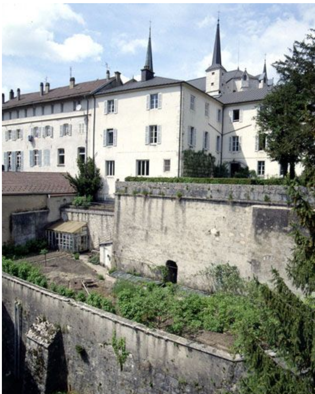
Vue générale des façades postérieures.
