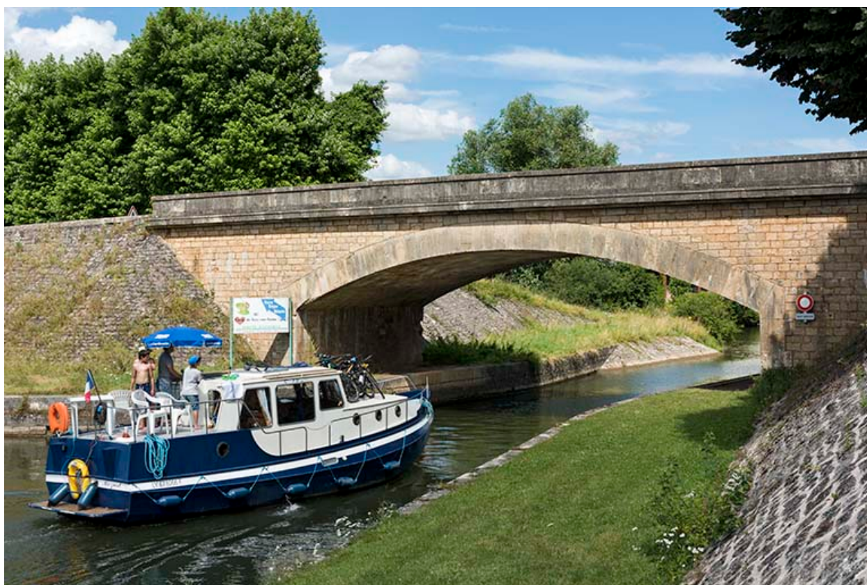
Le pont et son arc surbaissé.
