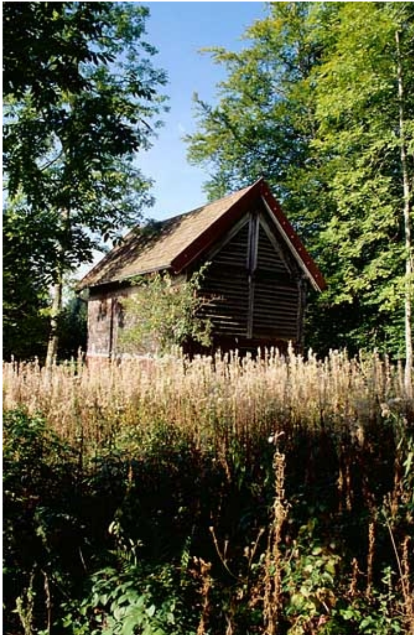
Vue de trois quarts du hangar séchoir.
