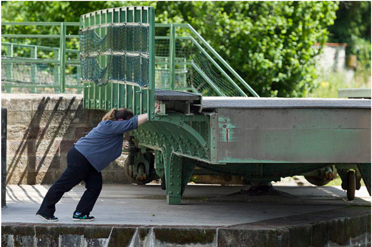
Rotation du pont par poussée manuelle.
